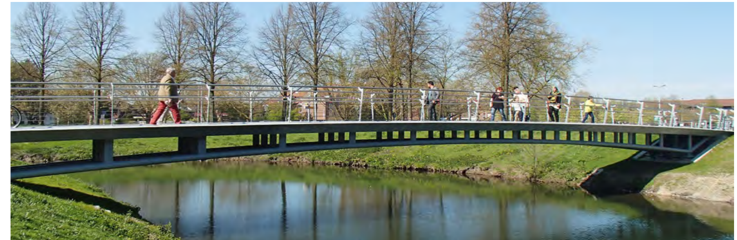
Schlank und transparent: Die Brücke fügt sich harmonisch in die Umgebung, Foto: Ib Cornelissen und Partner
