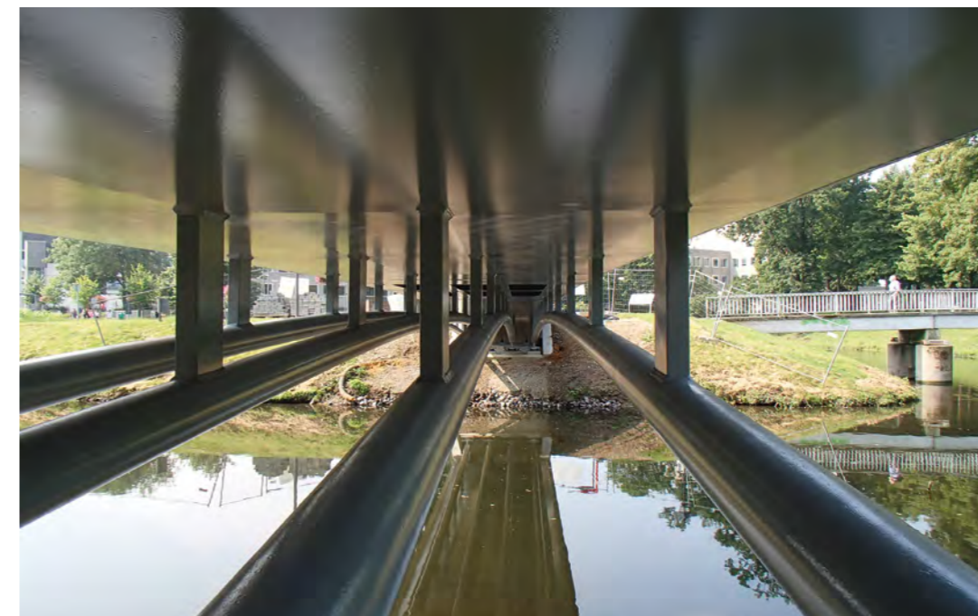
Untersicht der Tragkonstruktion, Foto: Ib Cornelissen und Partner
