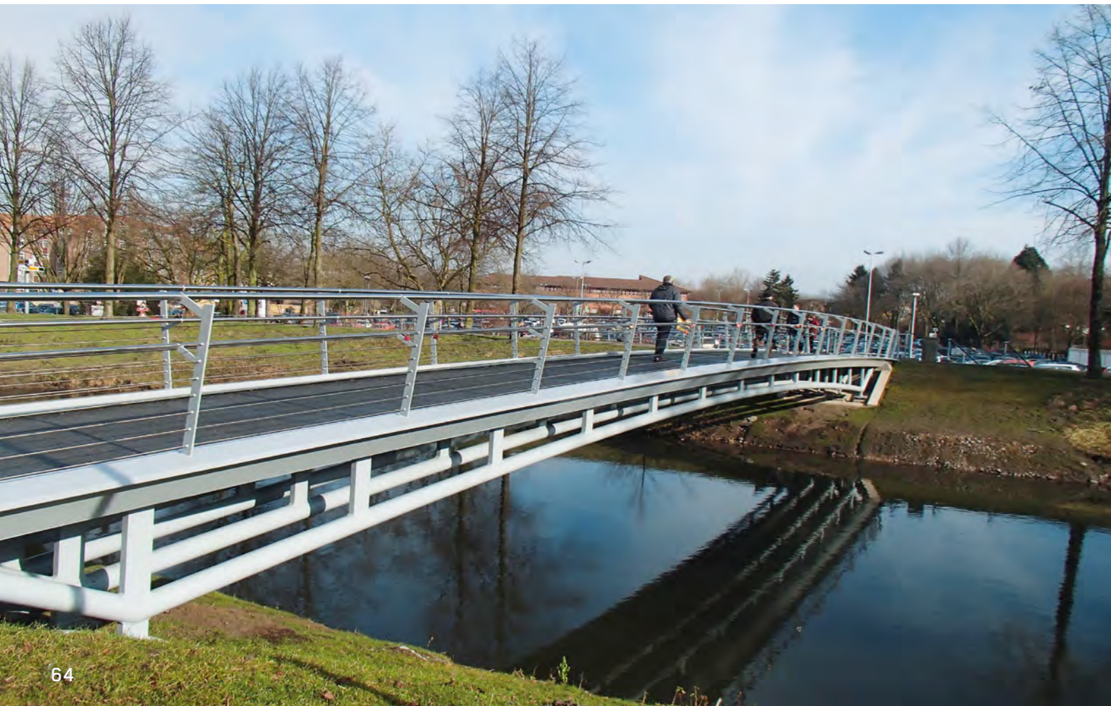
Die neue Brücke als Verbindung zwischen Nordring und Innenstadt, Foto: Ib Cornelissen und Partner
