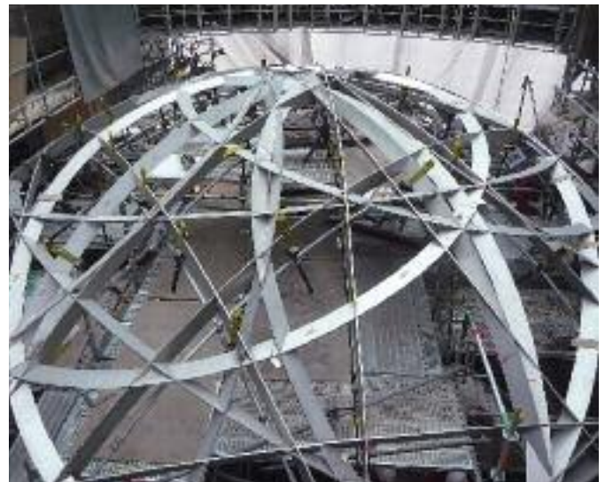
» Exakte Positionierung der Ringelemente mit Hilfe von Zangen
