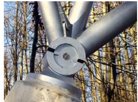
Als Korrosionsschutz für die Stahlkonstruktion wird das Duplexverfahren nach DB-Norm eingesetzt, mit drei Deckbeschichtungen auf einer Zinkgrundierung.
