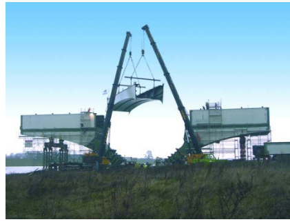
Einheben eines Brückenteils Elbebrücke Mühlberg©Straßenbauamt Leipzig
