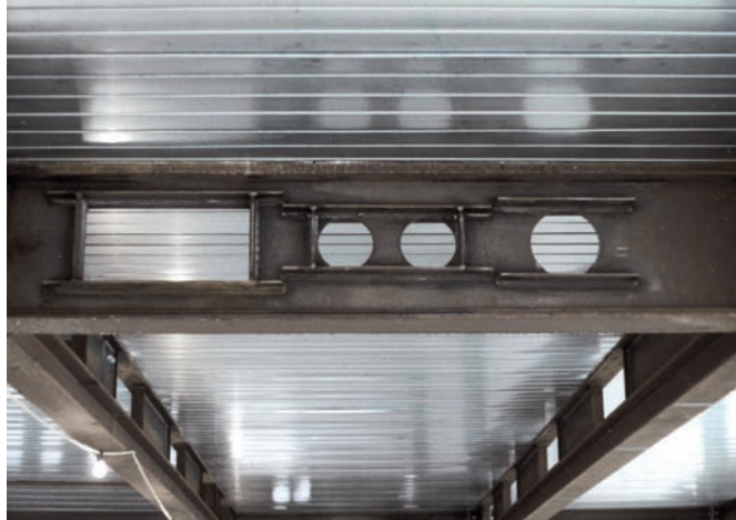
Bild 28: Stegdurchbrüche für die Installation
