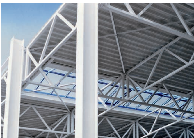
Bild 20: Fachwerkträger
