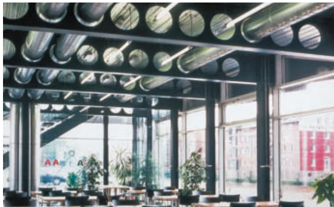
Bild 29: Installationsführung bei Lochstegträgern
