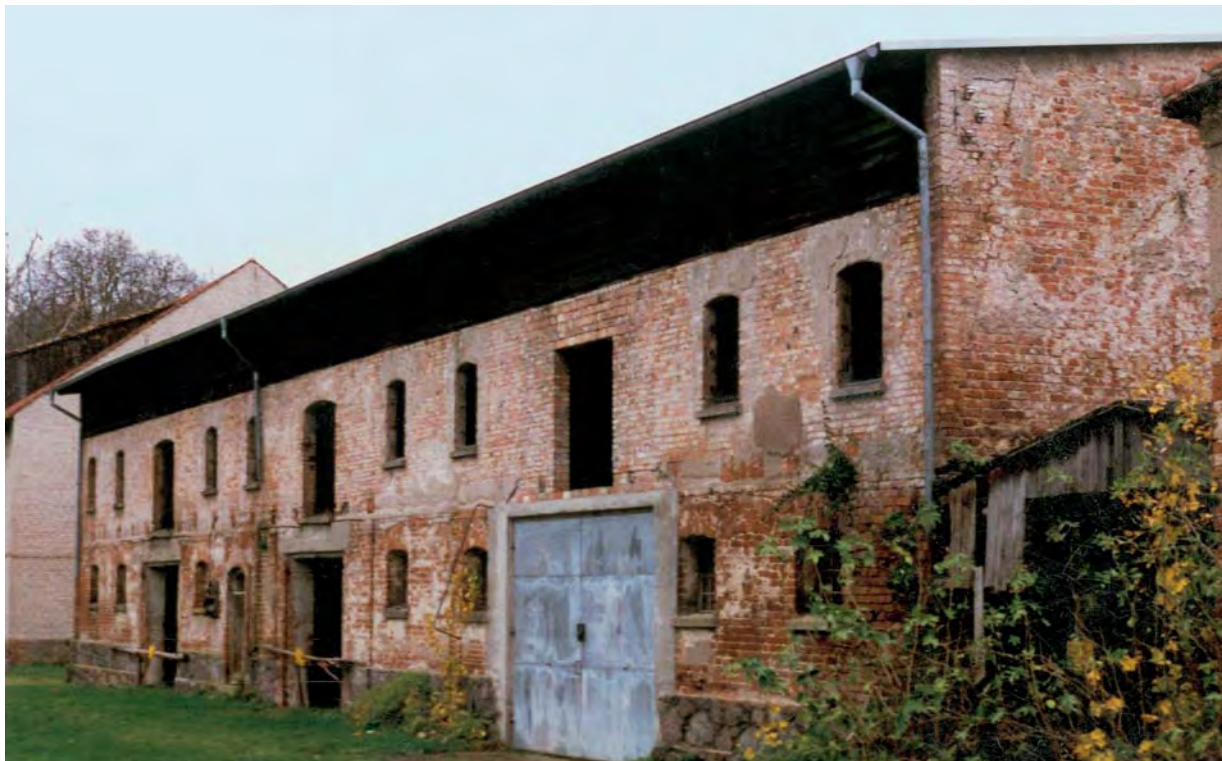
7.2 Zustand vor dem Umbau
