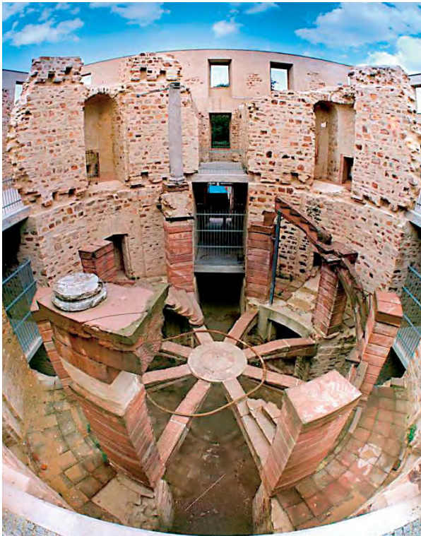
8.1 Innenraum der Ruine
