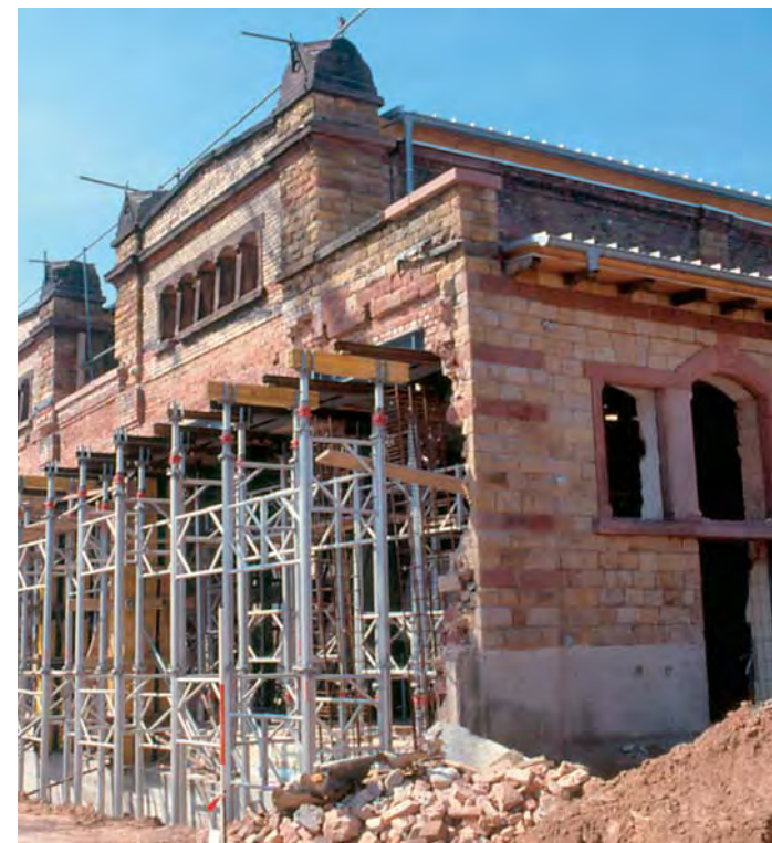
1.10 Montagezustand der Mauerwerksfassade
