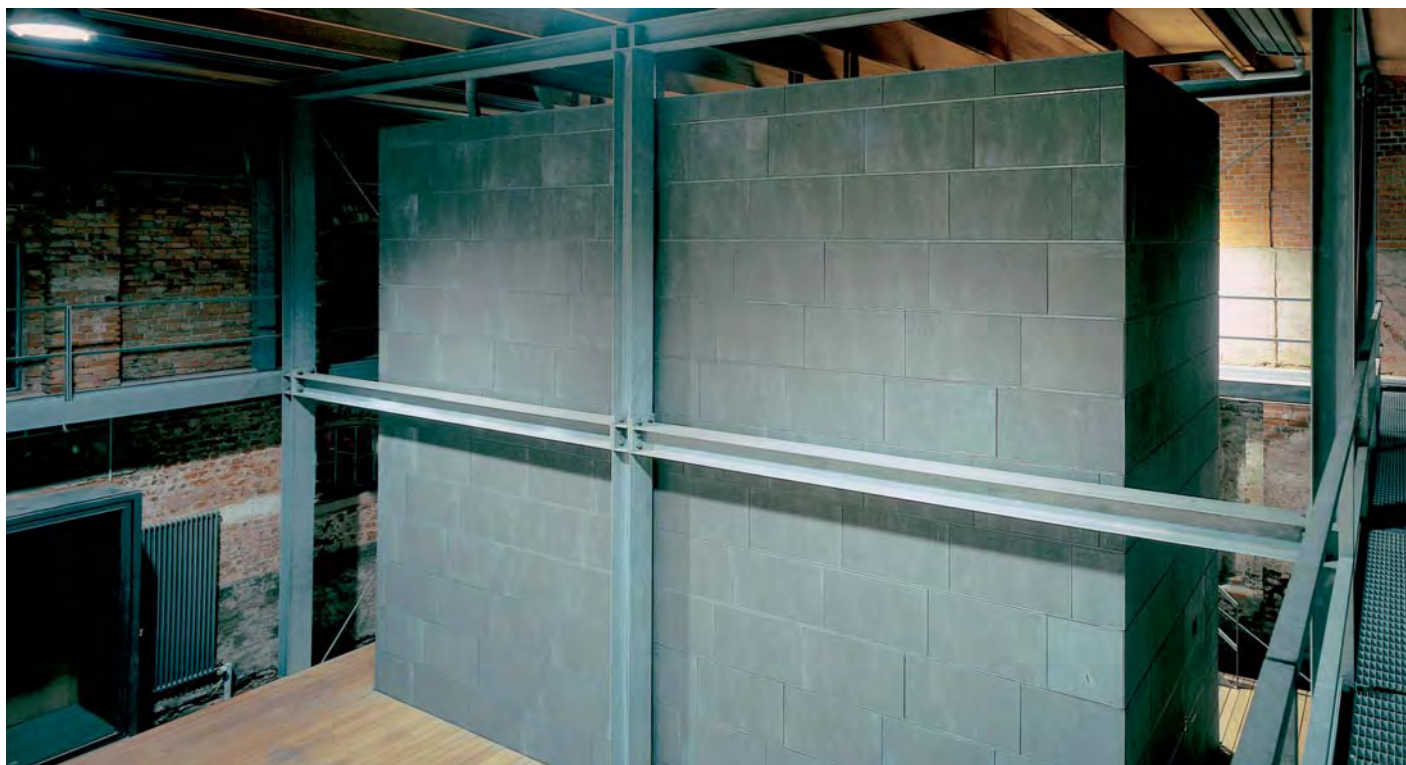
7.1 Innenraum – Stahlkonstruktion innerhalb des bestehenden Gebäudes
