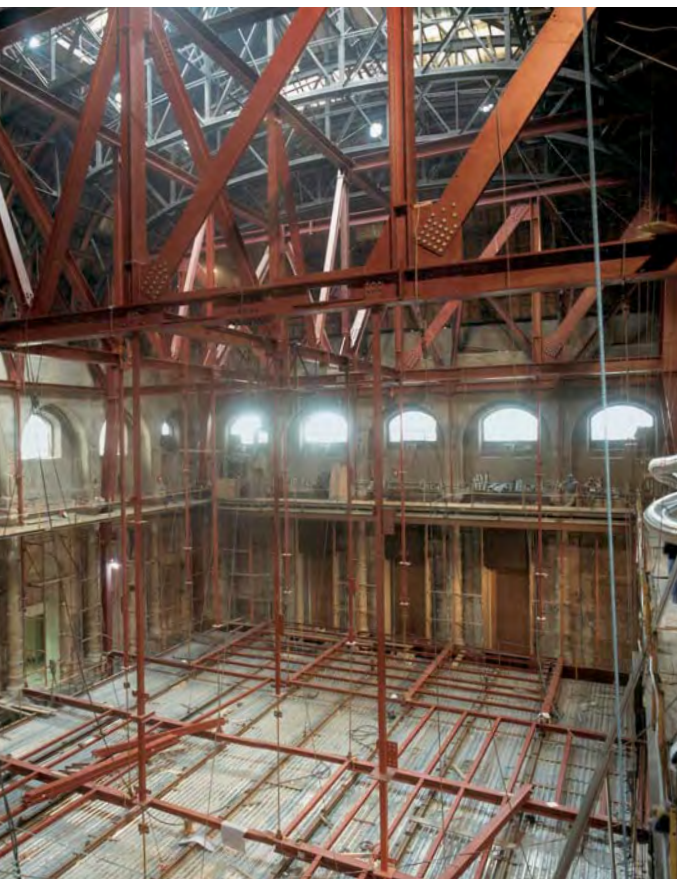
3.4 Montagearbeiten oberhalb der Sicherungsebene
