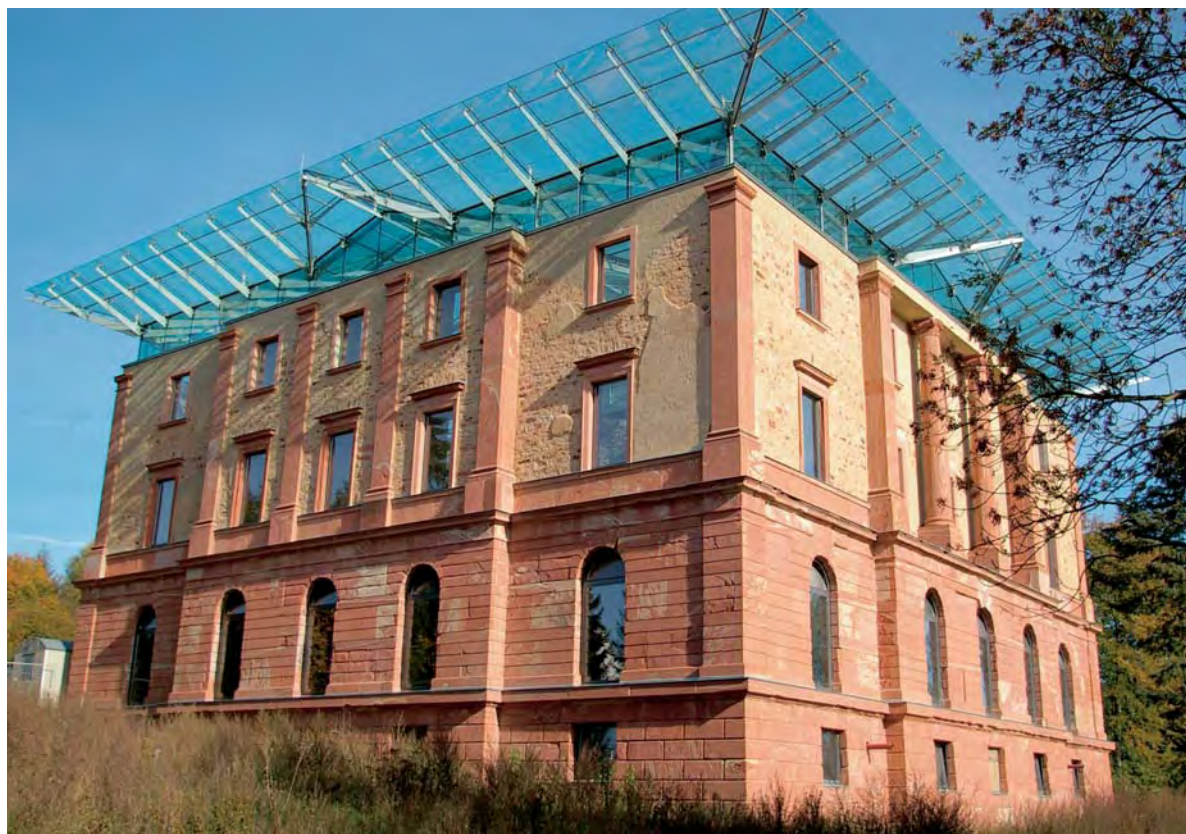
8.8 Neue Stahl-/Glasdachkonstruktion – Erinnerung an die ehemalige Dachform
