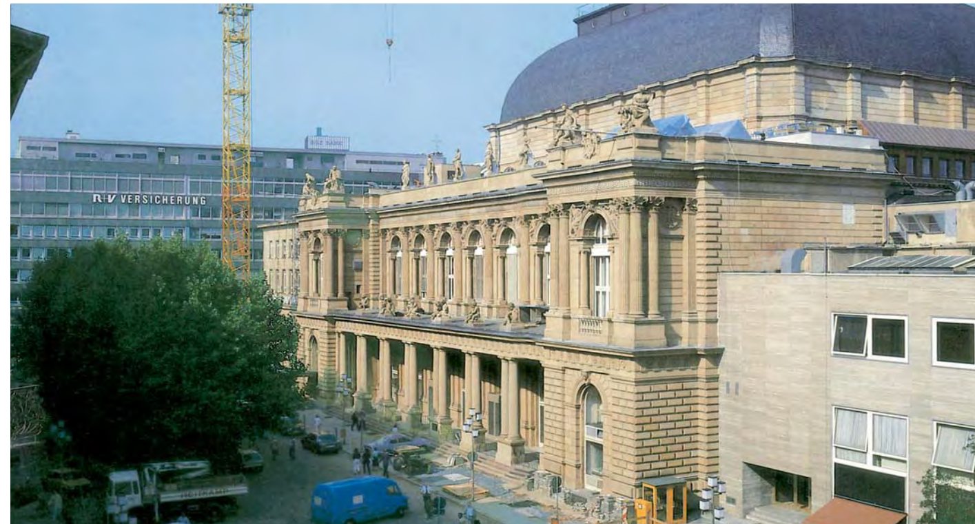
3.2 Ansicht des Börsengebäudes zu Beginn der Umbauarbeiten – 1985
