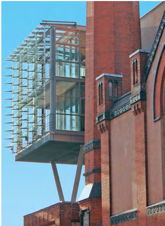
1.4 Blick von Nordosten
