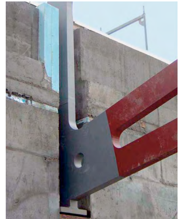
5.6 Auflagersituation der Stahlkonstruktion des Daches
