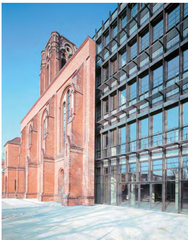
4.2 Schnittstelle zwischen alter und neuer Fassade
