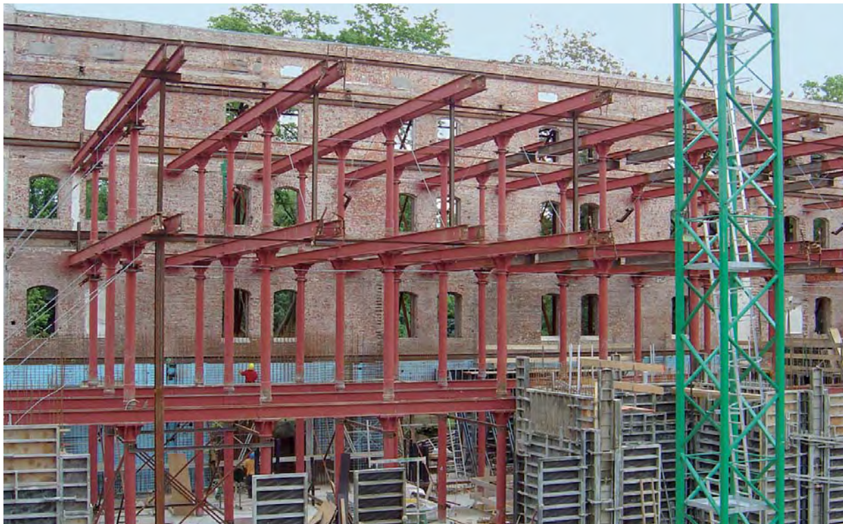
5.5 Montagezustand der erhaltenen Ostfassade
