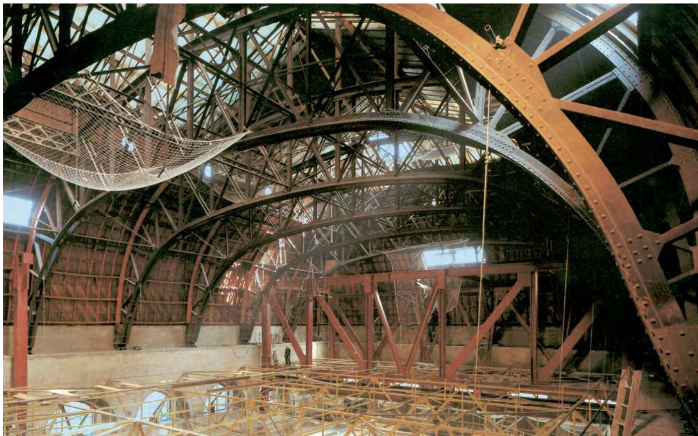
3.5 Einbau der Fachwerkbinder im Bereich der bestehenden Kuppelkonstruktion
