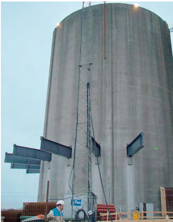
4.8 Montage der neuen Stahlkonstruktion
