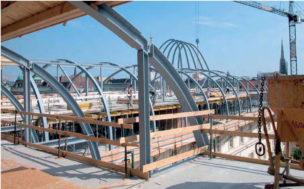
2.2 Montagezustand – primäre und sekundäre Konstruktion
