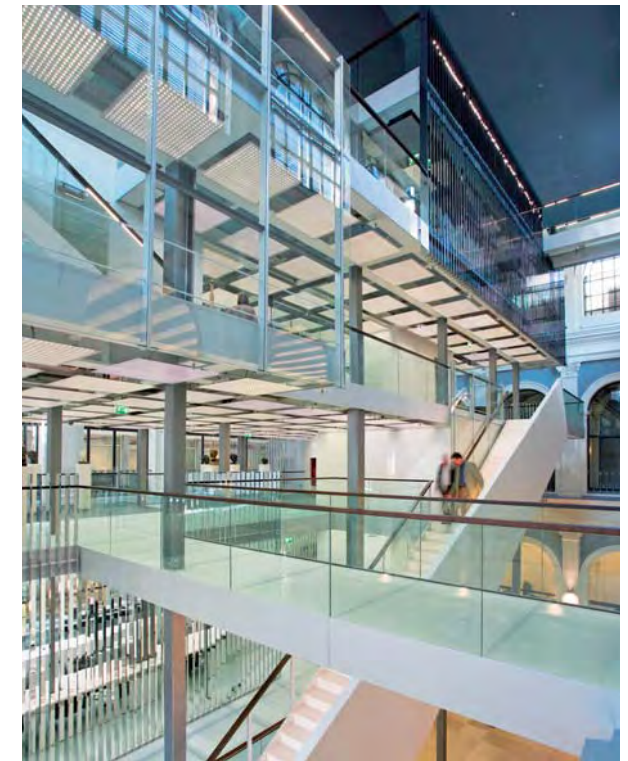
3.8 Verbindungsbrücke aus Stahl zwischen Bestand und Neubau
