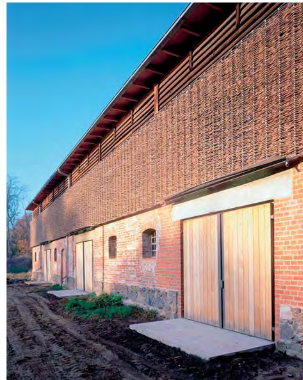
7.4 Zugangseite – Vorhang aus Weidengeflecht als Schlagregenschutz
