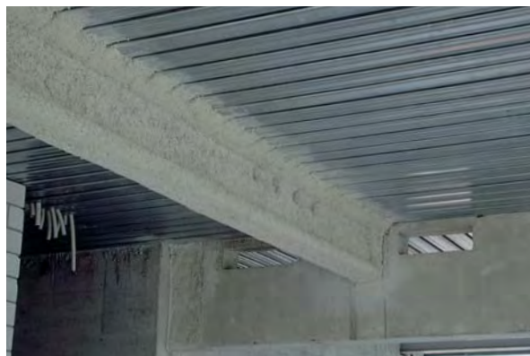
3 Spritzputz – raue, unregelmäßige Oberfläche
