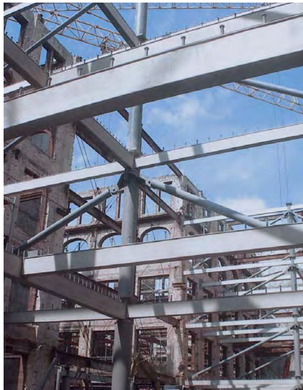
7.7 Montagephase der Stahlverbundträger
