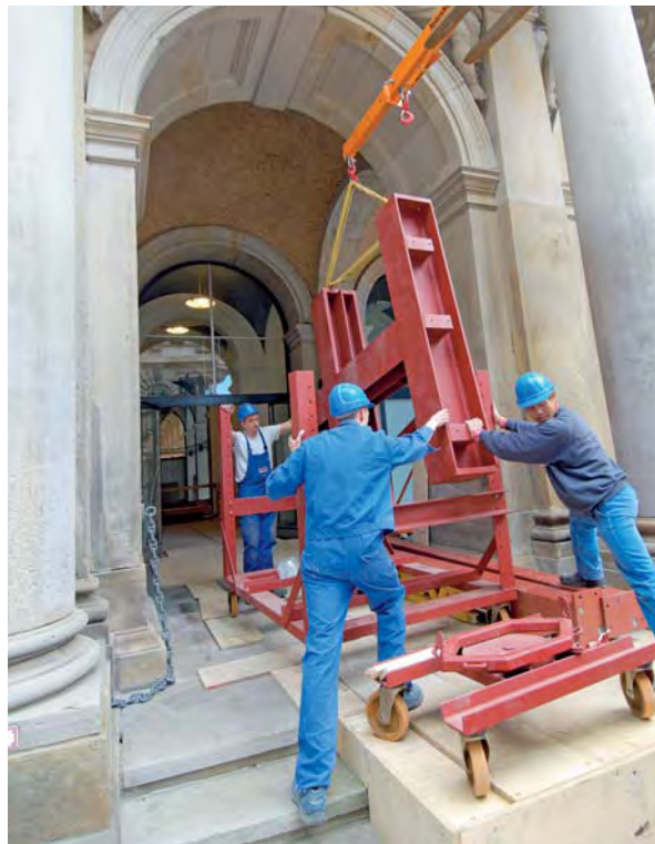
3.7 Bauteiltransport ins Gebäudeinnere
