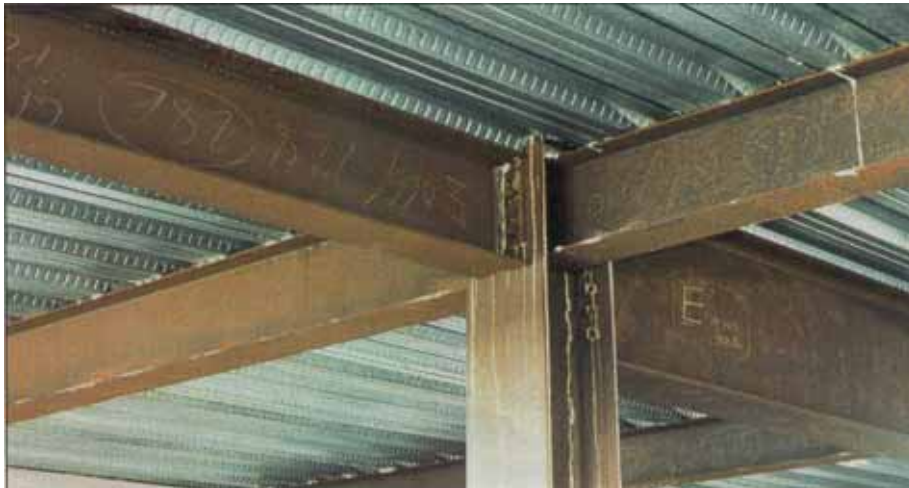
Abbildung 1.2: Ungeschützte Stahlkonstruktion [1]
