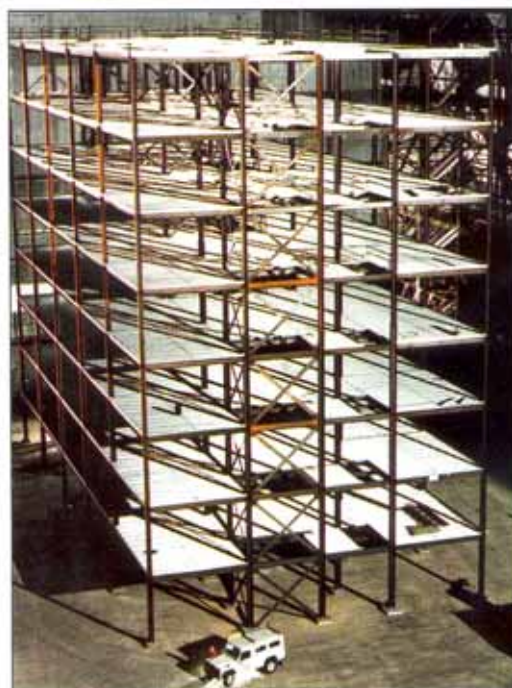
Abbildung 1.1: Cardington Versuchsgebäude vor der Betonage der Decken [1]
