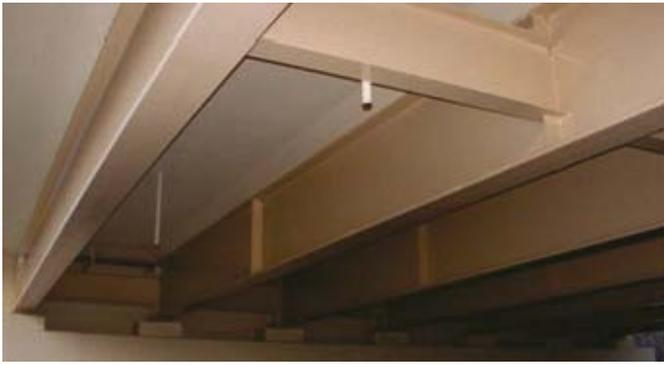
Bild 19: Detailausführung I-Querträger mit Hauptträgersteg verschweißt
