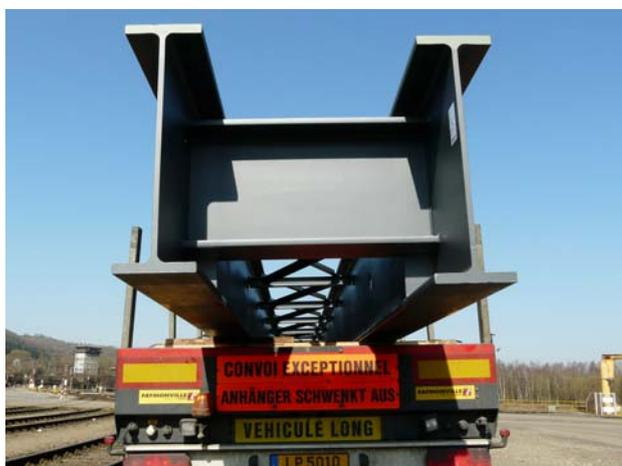
Bei beiden Varianten eines geschweißten Querträgeranschlusses ist zu beachten, dass die Breite der durch die Querträger gruppierten Längsträger nicht die Breite der Verzinkungsbäder überschreitet. Von einer prinzipiell möglichen Verzinkung der um 90° gedrehten Verbaugruppe mit dann liegenden Längsträgern wird abgeraten, da die Qualität der Verzinkung negativ beeinflusst wird.
