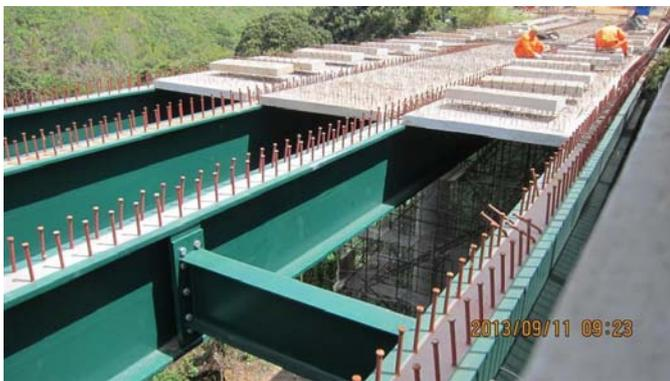
Bild 15: Detailausführung geschraubter Anschluss eines I-Querträgers an eine an den Hauptträger geschweißte T-Rippe; Praxisbeispiel Bauzustand
