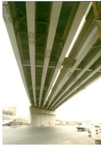
Bild 24: Geschraubter Laschenstoß der Hauptträger einer Verbundbrücke in Istanbul, Türkei
