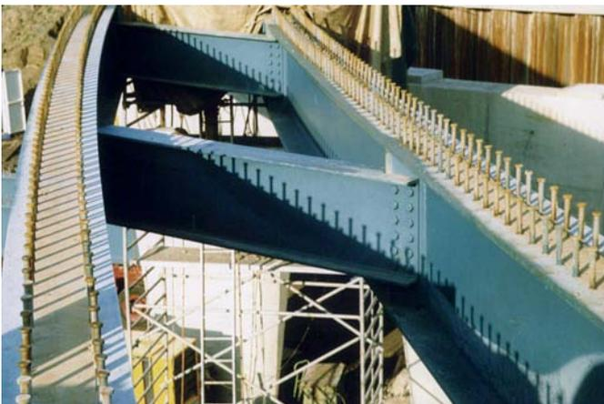
Bild 16: Detailausführung geschraubter Anschluss eines U-Querträgers mit Aussteifungsblech verschraubt; links: Praxisbeispiel Bauzustand; rechts: verzinkungsgerechte Ausführung mit Durchflussöffnungen
