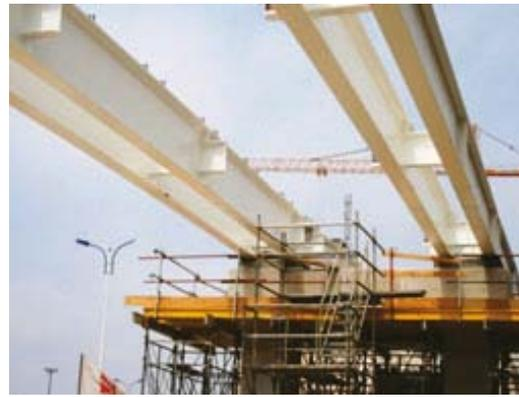
Bild 20: Einheben vormontierter Trägerpaare und nachträgliches Verschweißen von I-Querträger an vorgefertigte Trägerstummel
