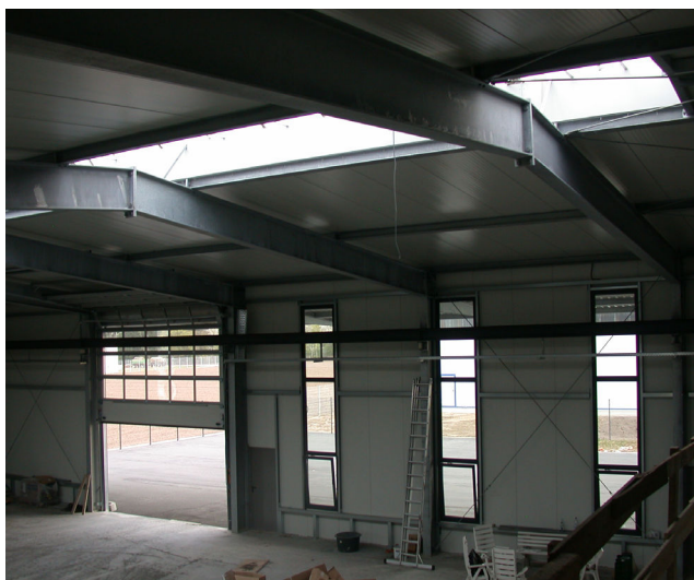
Bild 1: Baufortschritt einer Halle nach Musterstatik bfs e.V. (Innen)
