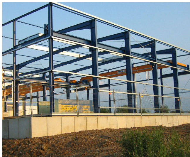
Bild 3: Baufortschritt einer Halle nach Musterstatik bfs e.V. (Außen)
