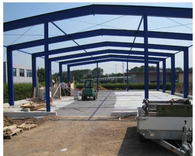
Bild 2: Baufortschritt einer Halle nach Musterstatik bfs e.V. (Außen)
