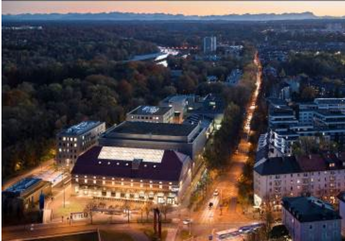
Foto 1 (Halle E, Isarphilharmonie und das gesamte Gelände des Gasteig HP8 © HGEsch/Gasteig)
