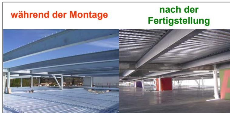
Abbildung 36 Anwendungsbeispiel für die Brandschutzbemessung mit einer globalen Tragwerksanalyse unter Naturbrandbeanspruchung
