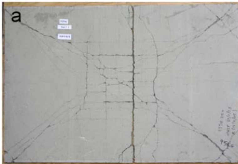
Überlastbruch der Bewehrung
