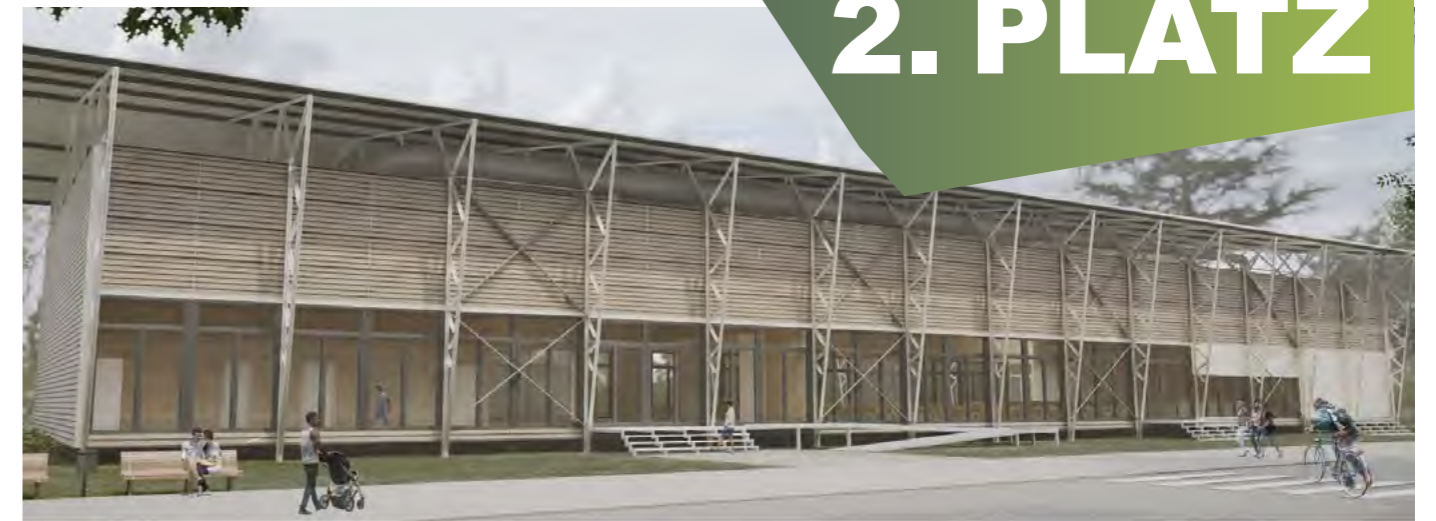
Die temporäre Aula basiert auf einem modularen Stahltragwerk mit vorgefertigten Holzelementen.
