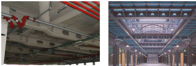
Bild 1 - Stahlträger mit großflächigen Stegöffnungen: Optimierte Leichtbaukonstruktion für die Integration von Gebäudetechnik (links) und die Erfüllung hoher architektonischer Ansprüche (rechts)
