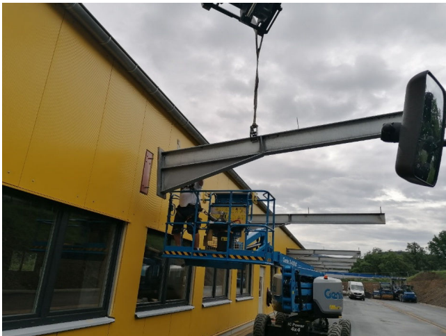
Abbildung 2 - Vordachkonstruktion mit thermischer Trennschicht (Quelle Calenberg-Ingenieure)
