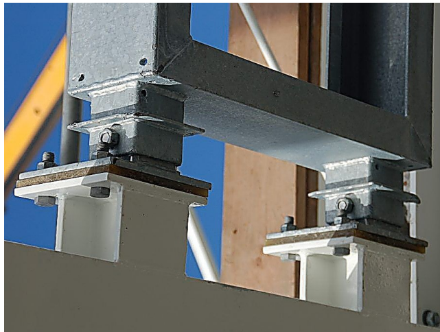
Abbildung 3 - Fußpunktausbildung mit thermischer Trennschicht (Quelle Farrat GmbH)
